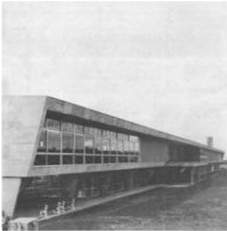
Fig. 43. Fotografía del bloque de aulas del colegio experimental Paraguay-Brasil. DIARTE, JULIO (2009) RECONSTRUCCIÓN DEL PROYECTO. COLEGIO EXPERIMENTAL PARAGUAY-BRASIL. AFFONSO EDUARDO REIDY 1952-65. p. 65. Este bloque fue el único construido de todo el proyecto, el mismo fue inaugurado en 1965, se lo proyecto en 1952.
